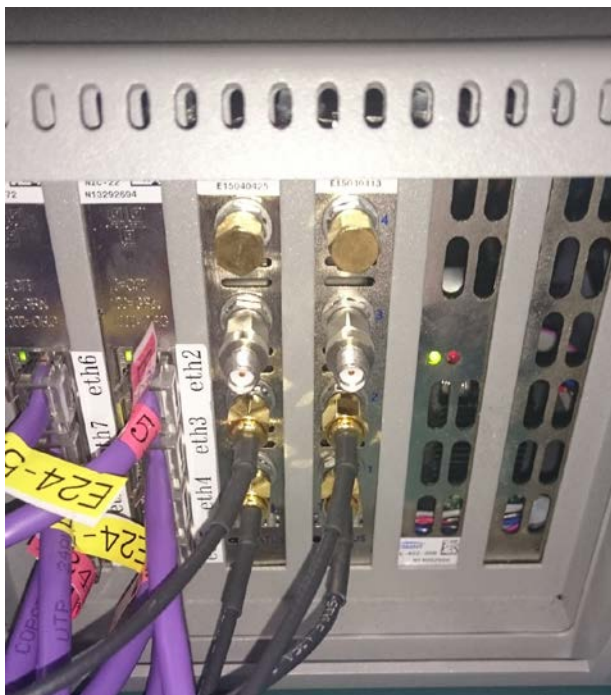
図 3 テスト用配線 (試験機側 RF 接続部近接)
